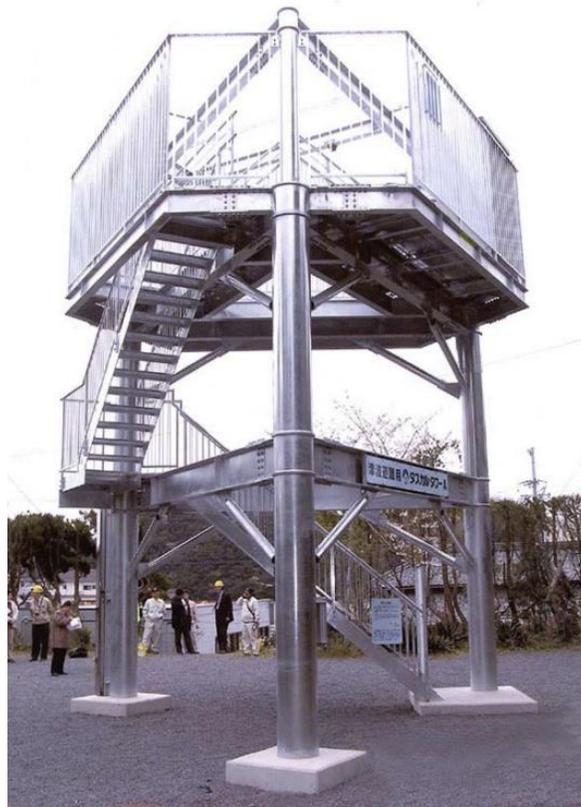
**Figura 24:** Estructura de desalojo vertical en Japón (Tomada de FEMA P646A).
